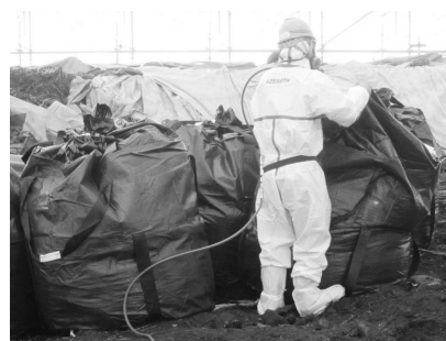
全身、防護服で袋詰めする作業員
