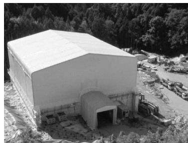
掘削用の巨大なテント
